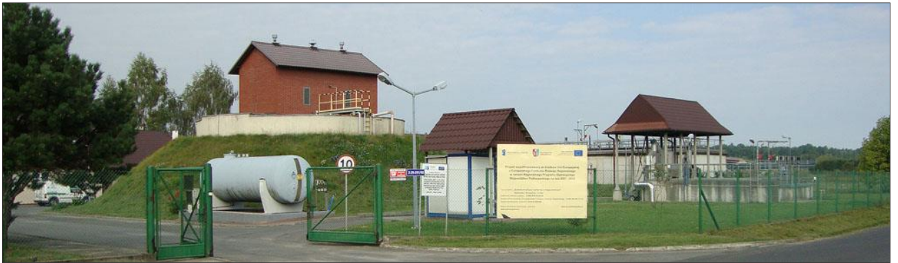
Fot. Oczyszczalnia ścieków w Skrzyszowie.
