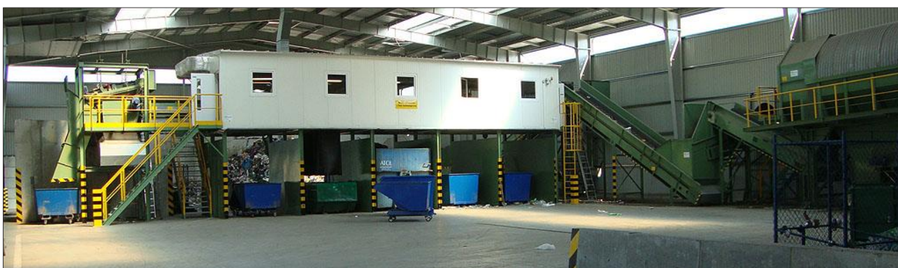
Fot. Zakład Zagospodarowania Odpadów w Kozodrzy - hala sortowni.
